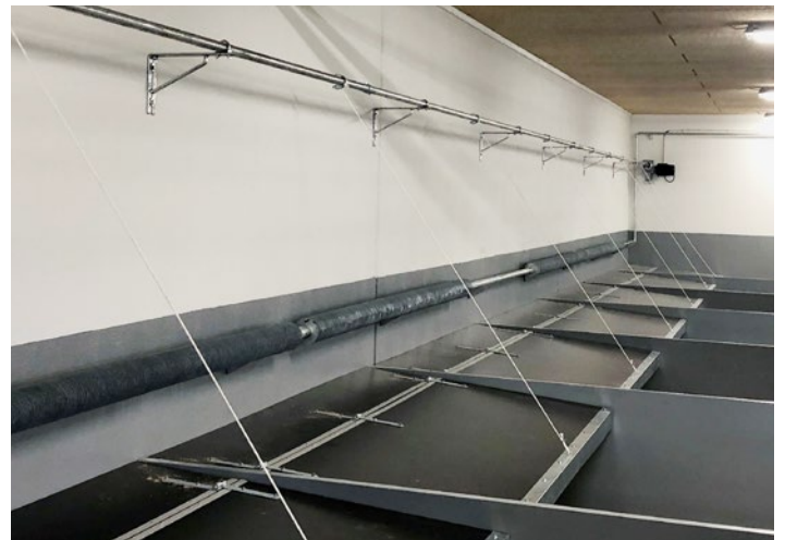
Zweigeteilte Abdeckung aus Holz mit zentraler Öffnung
