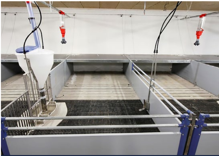
Abferkelbucht mit Zweiklimasystem und ad-libitum-Trockenfütterung
