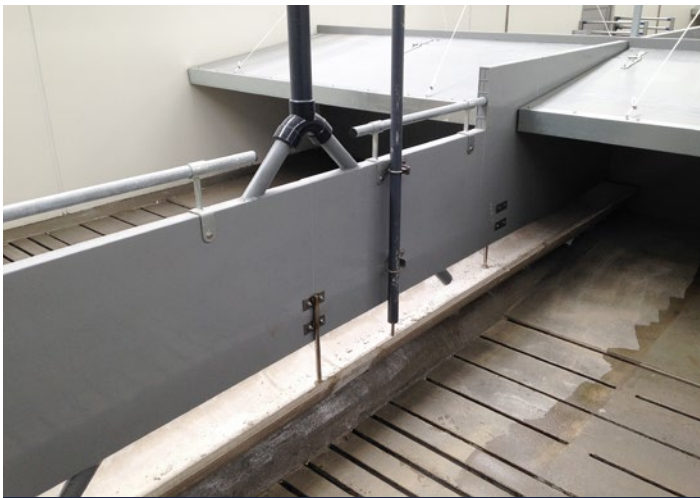
Slagtesvinesti med integreret våfoderrør
