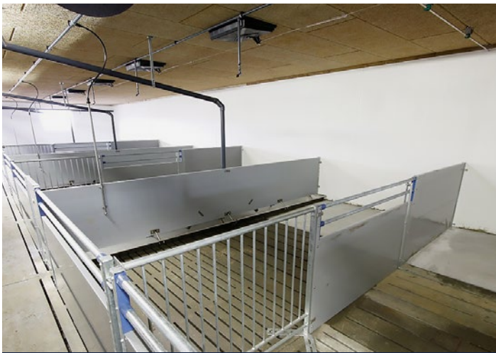
Mastschweinebucht mit Flüssigfütterung
