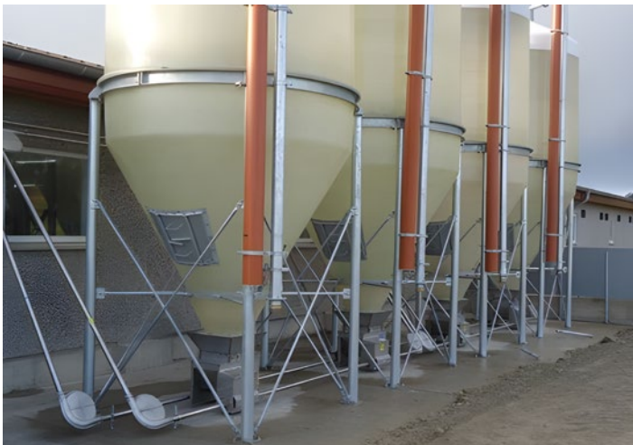
Siloer med udtag til fodringsanlæg og PVC-udluftning.
