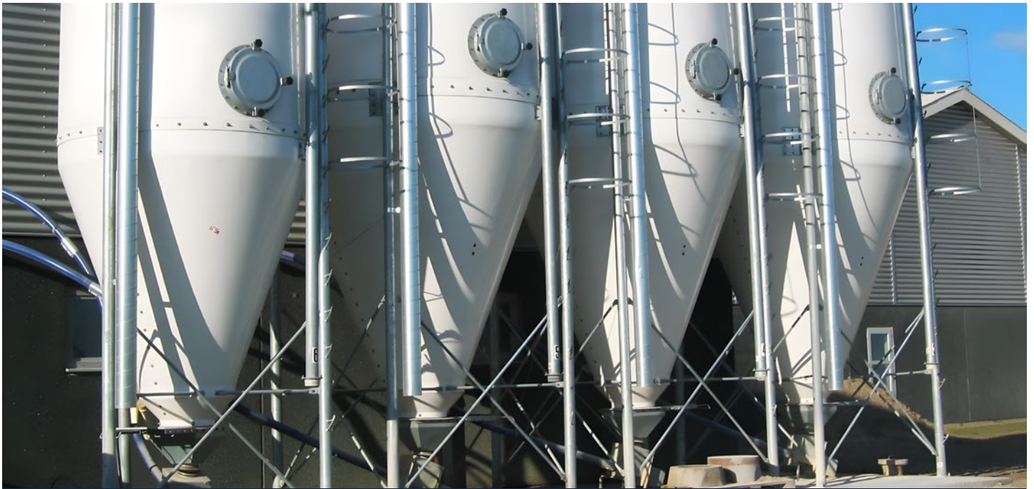
Silobatteri med flexsnegle og inspektionsluge.
